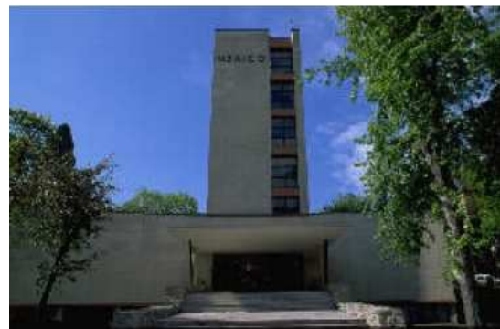
Figure 4: The side view of the "Maison du Mexique".
